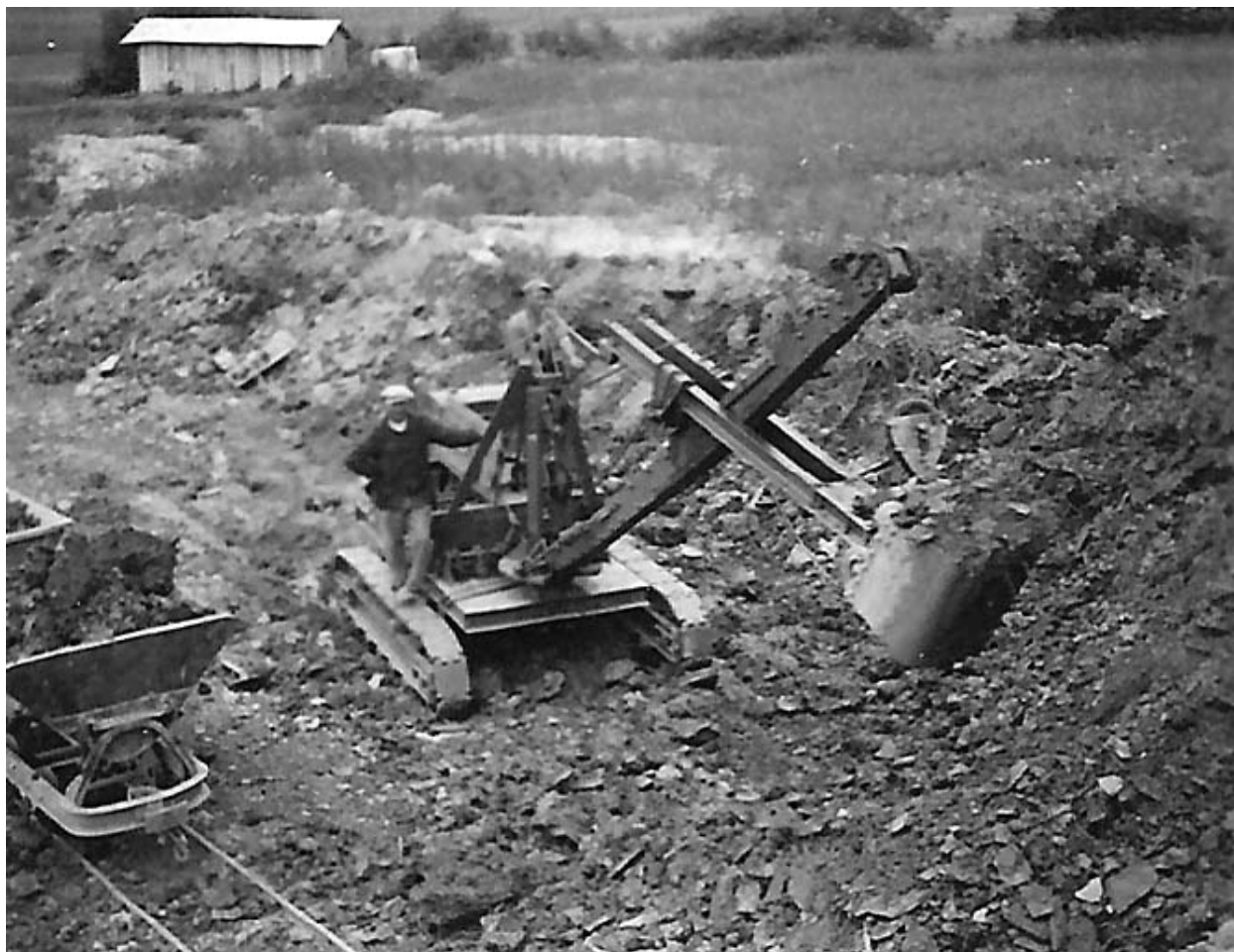
La pelle mécanique. Chargement d'un wagonnet.
