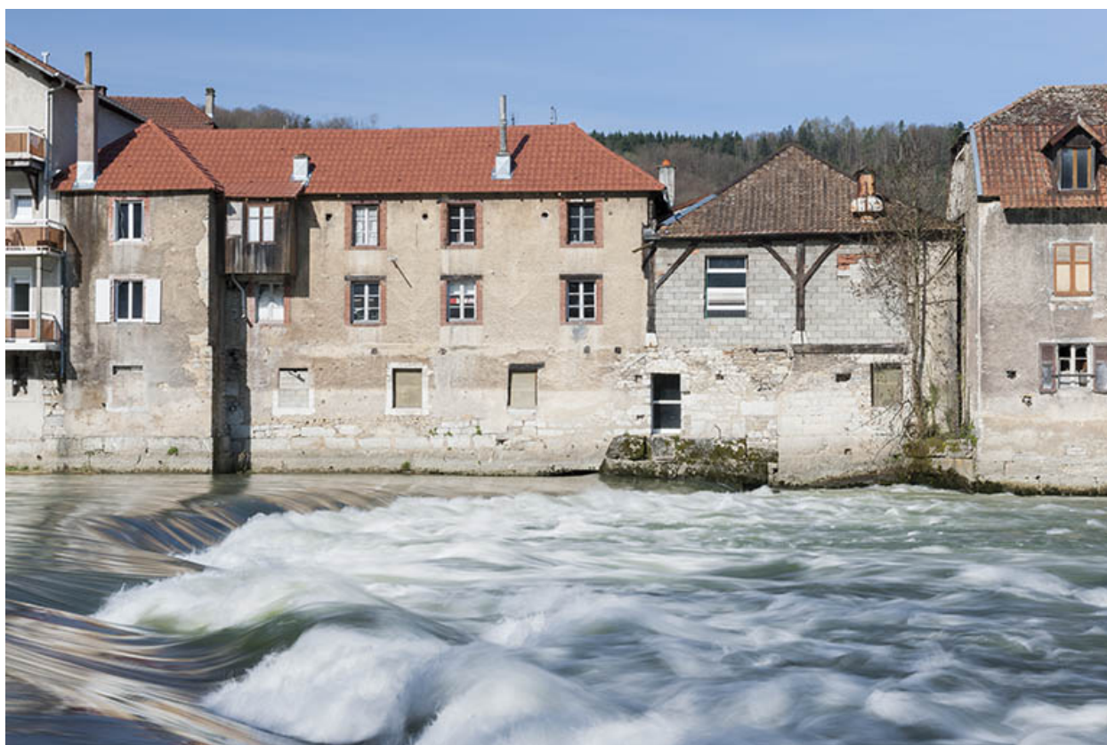
Façade sur le Doubs des ateliers.
