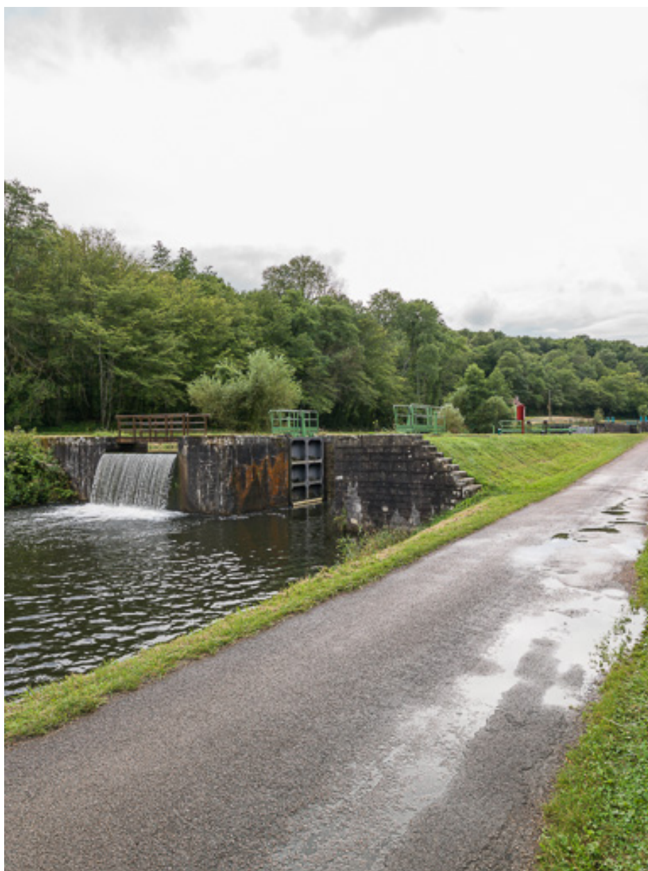
Vue du déversoir de superficie.
