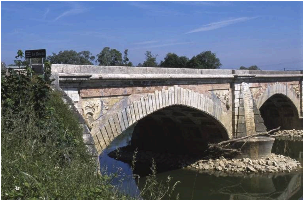
Détail d'une arche.
