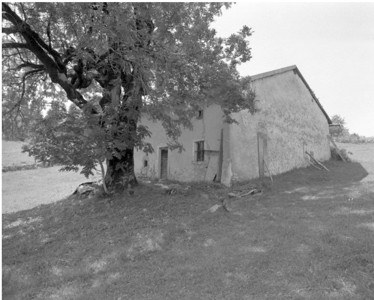
Façade antérieure et face droite.
