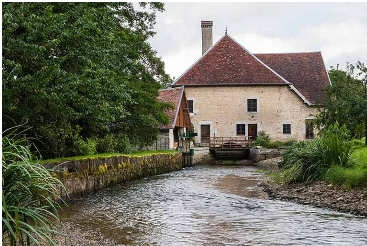
Vue depuis l'amont (canal d'amenée vidé).
