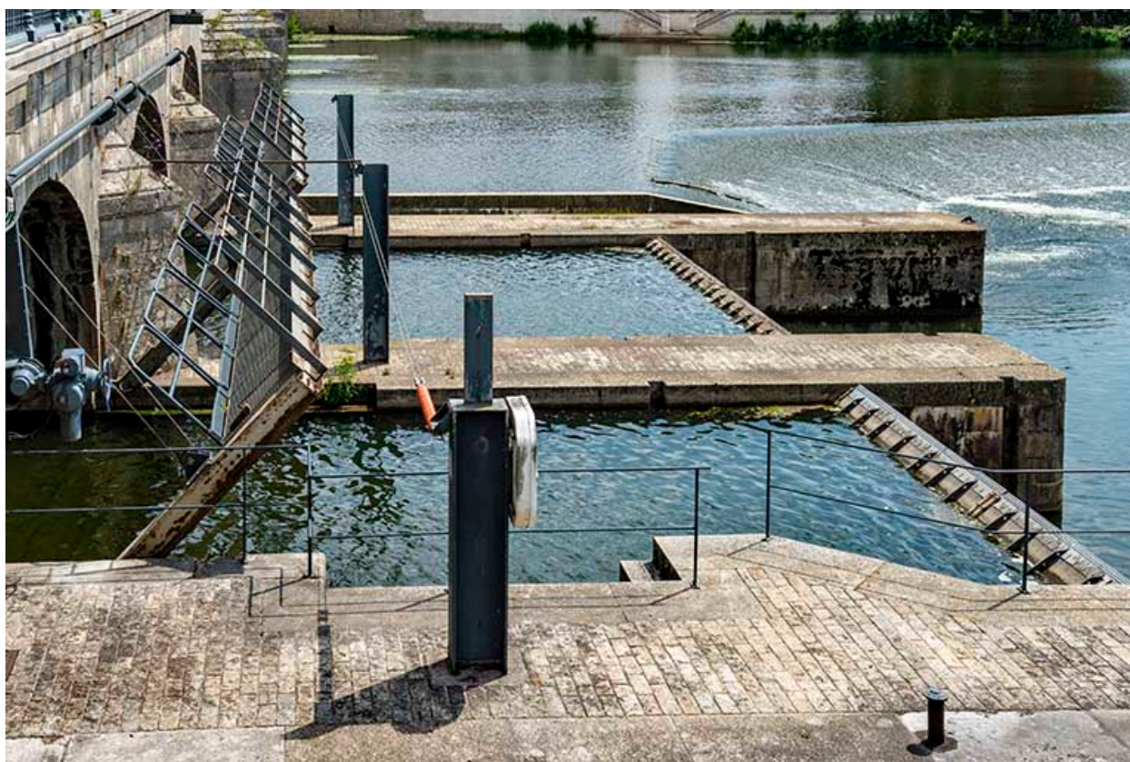
La partie mobile du barrage de Gray.
