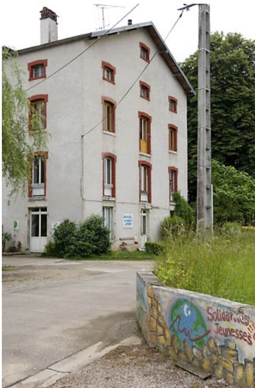
Elévation occidentale de l'atelier de fabrication.
