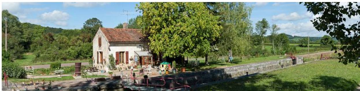
Vue d'ensemble du site d'écluse.
