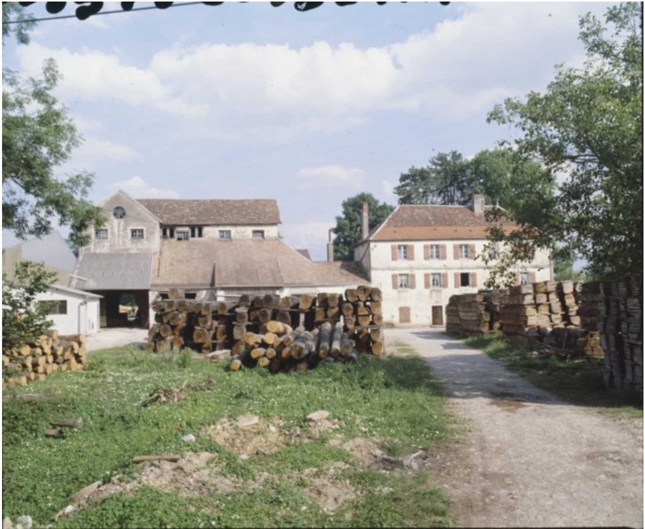
Vue d'ensemble depuis l'entrée du site en 1989.
