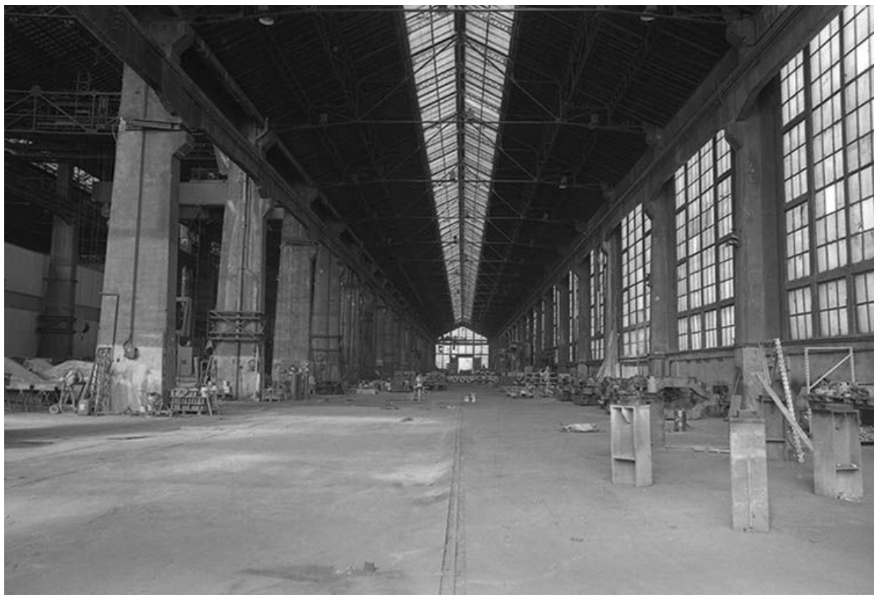
Intérieur de la travée E de la fonderie de fonte, vu de l'entrée nord.
