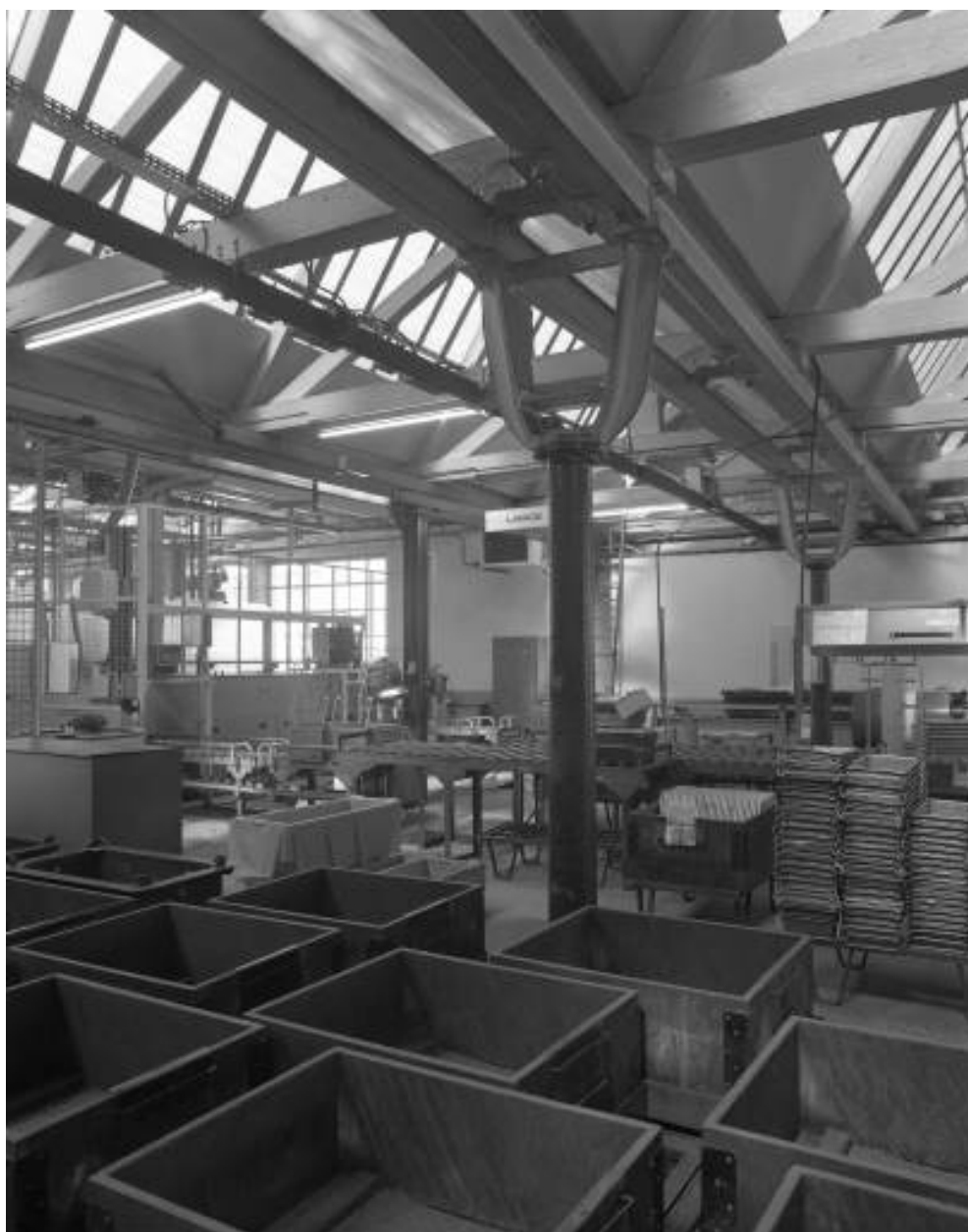
Atelier des culbuteurs. Charpente en bois.
