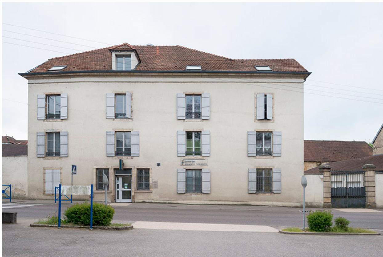
Vue générale du bâtiment.
