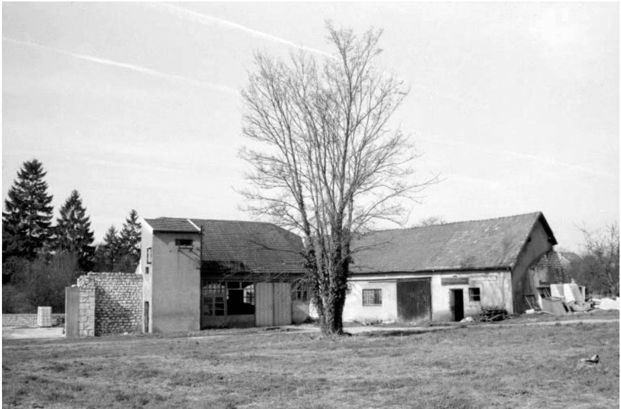
Fabrique d'aliment pour bétail : écuries et transformateur.
