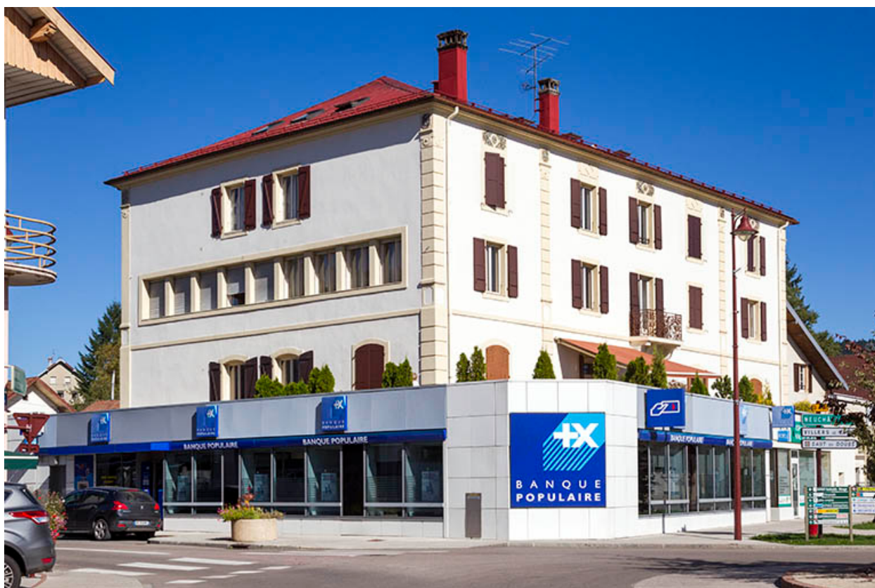
Façades antérieure et latérale gauche.
