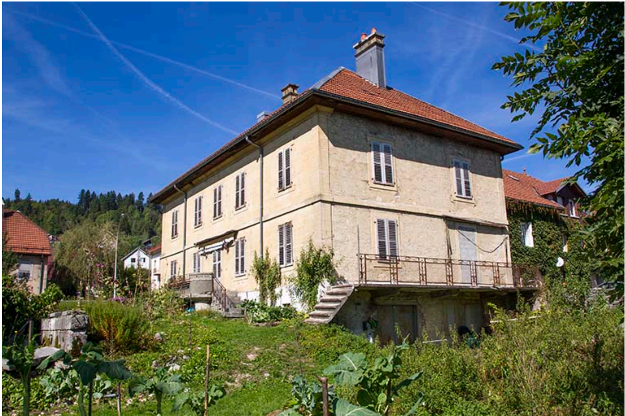
Corps sud : façades postérieure et latérale droite.
