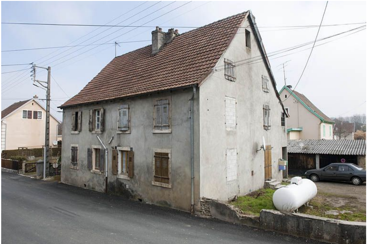
Immeuble à 4 logements dit "la Bastille".
