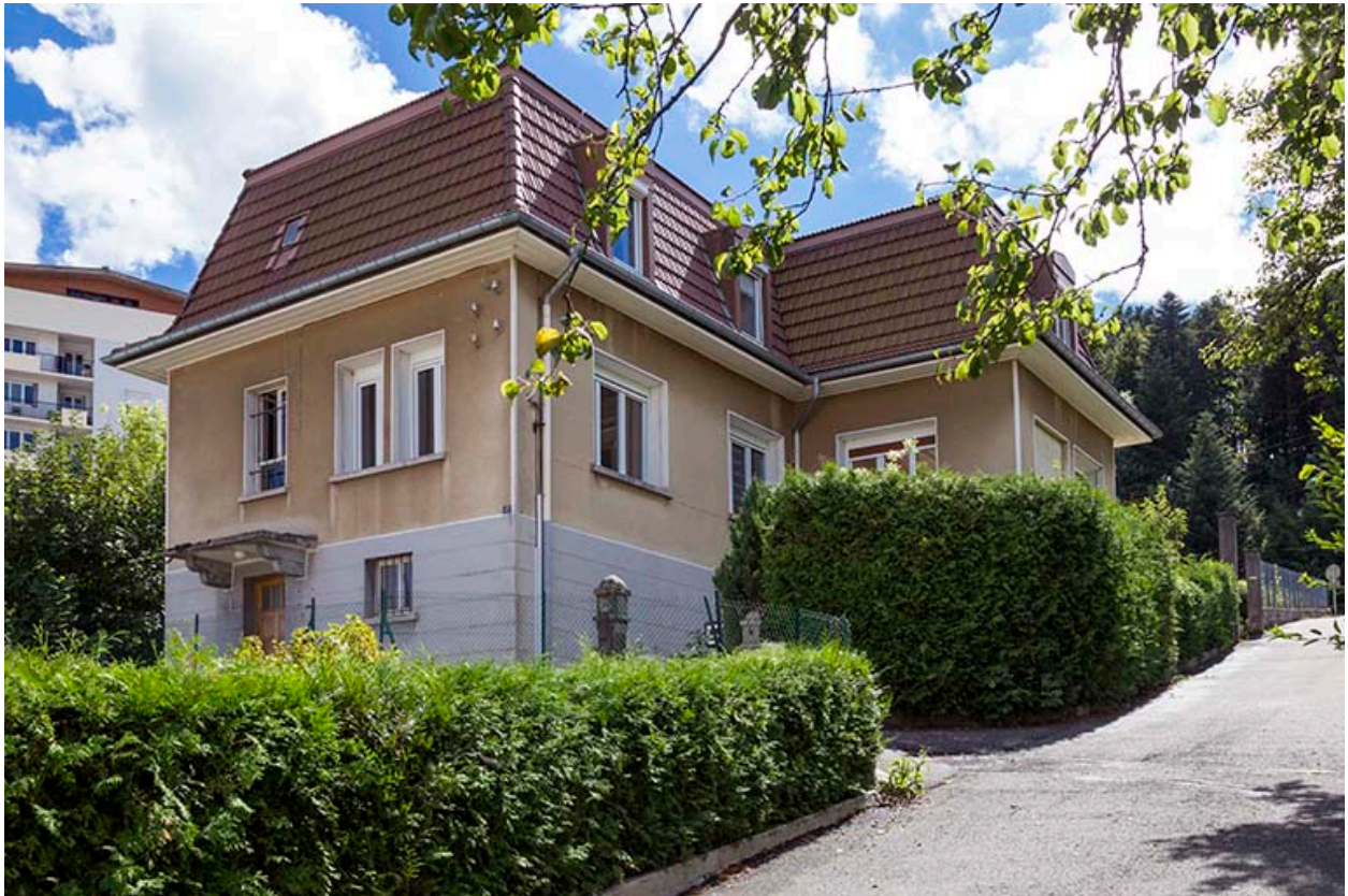
Façades antérieure et latérale droite.
