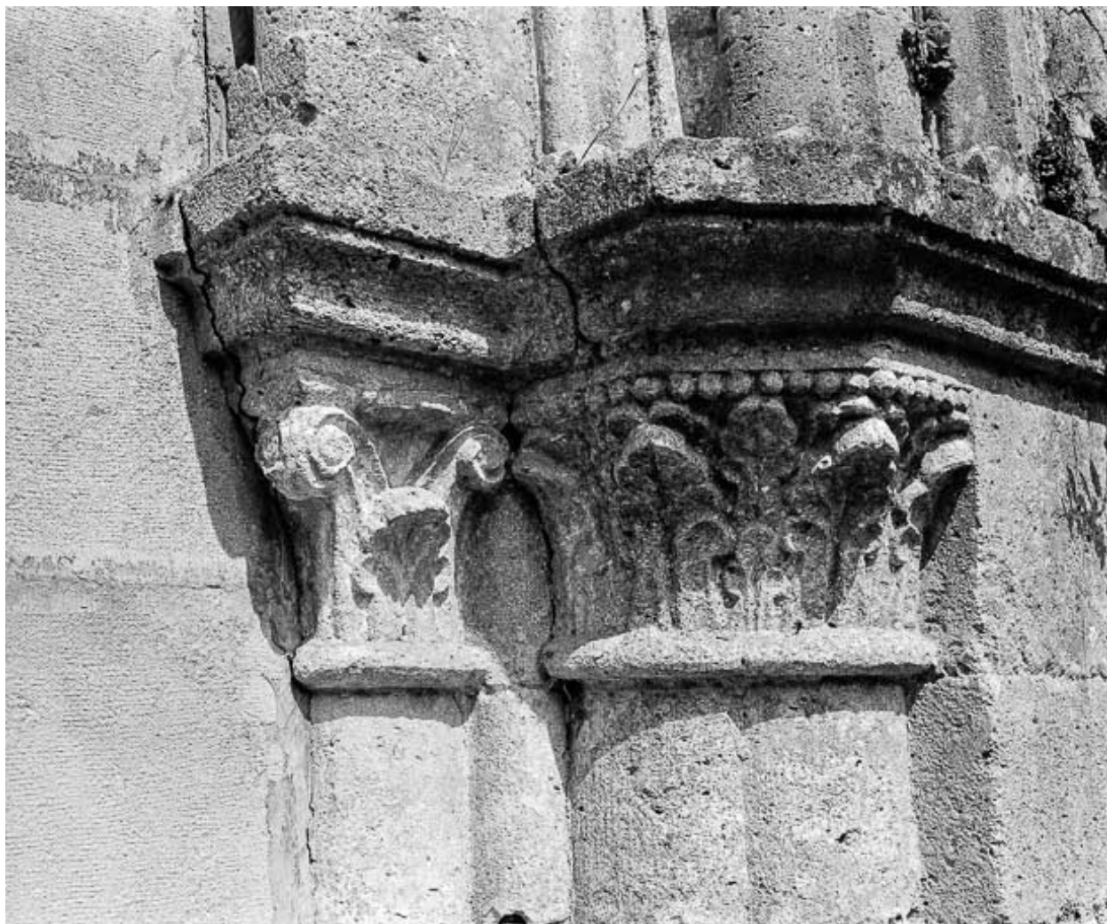
Détail : chapiteaux droits du porche.
