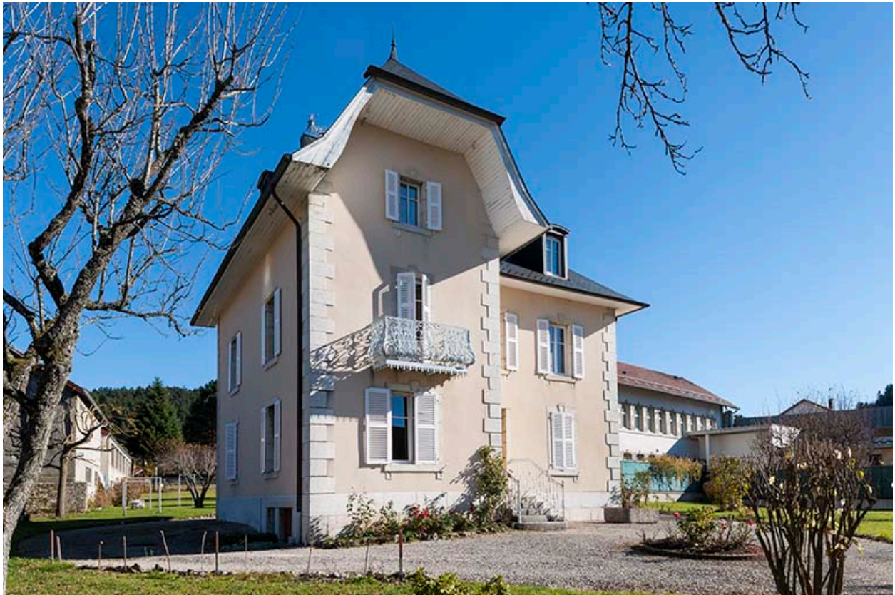
Logement patronal : façades antérieure et latérale gauche.
