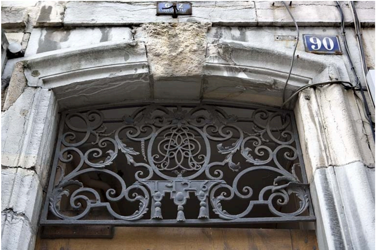
Détail du tympan en ferronnerie de la porte du couloir.
