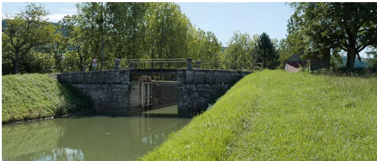
Vue du pont depuis l'aval.
