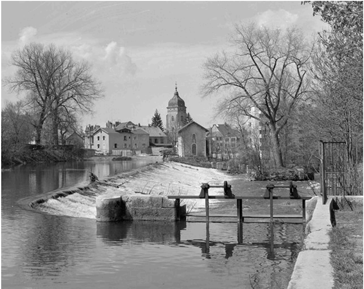
Le barrage et le bâtiment d'eau en 1980.
