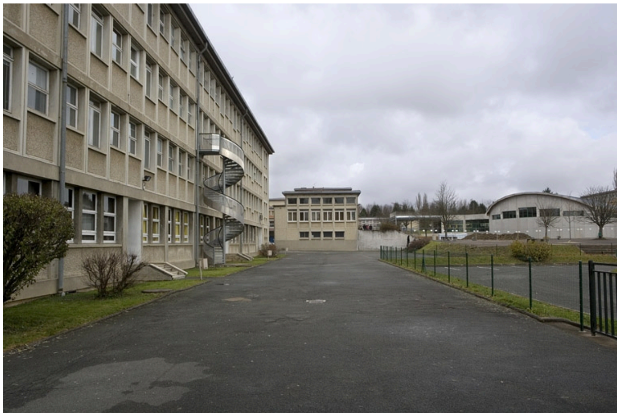
Vue latérale façade antérieure bâtiment D.
