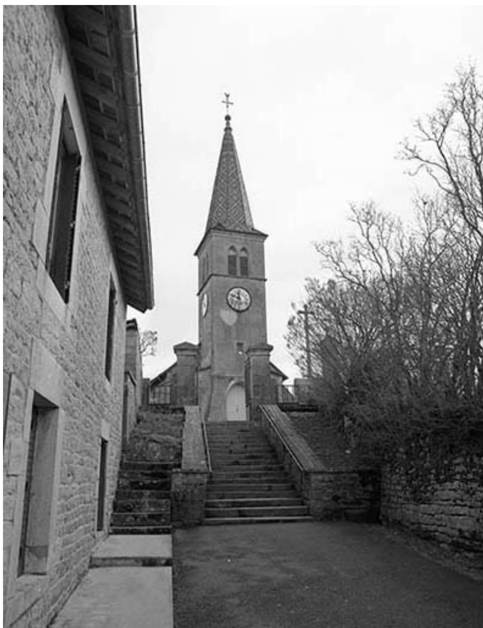
Extérieur : façade antérieure.
