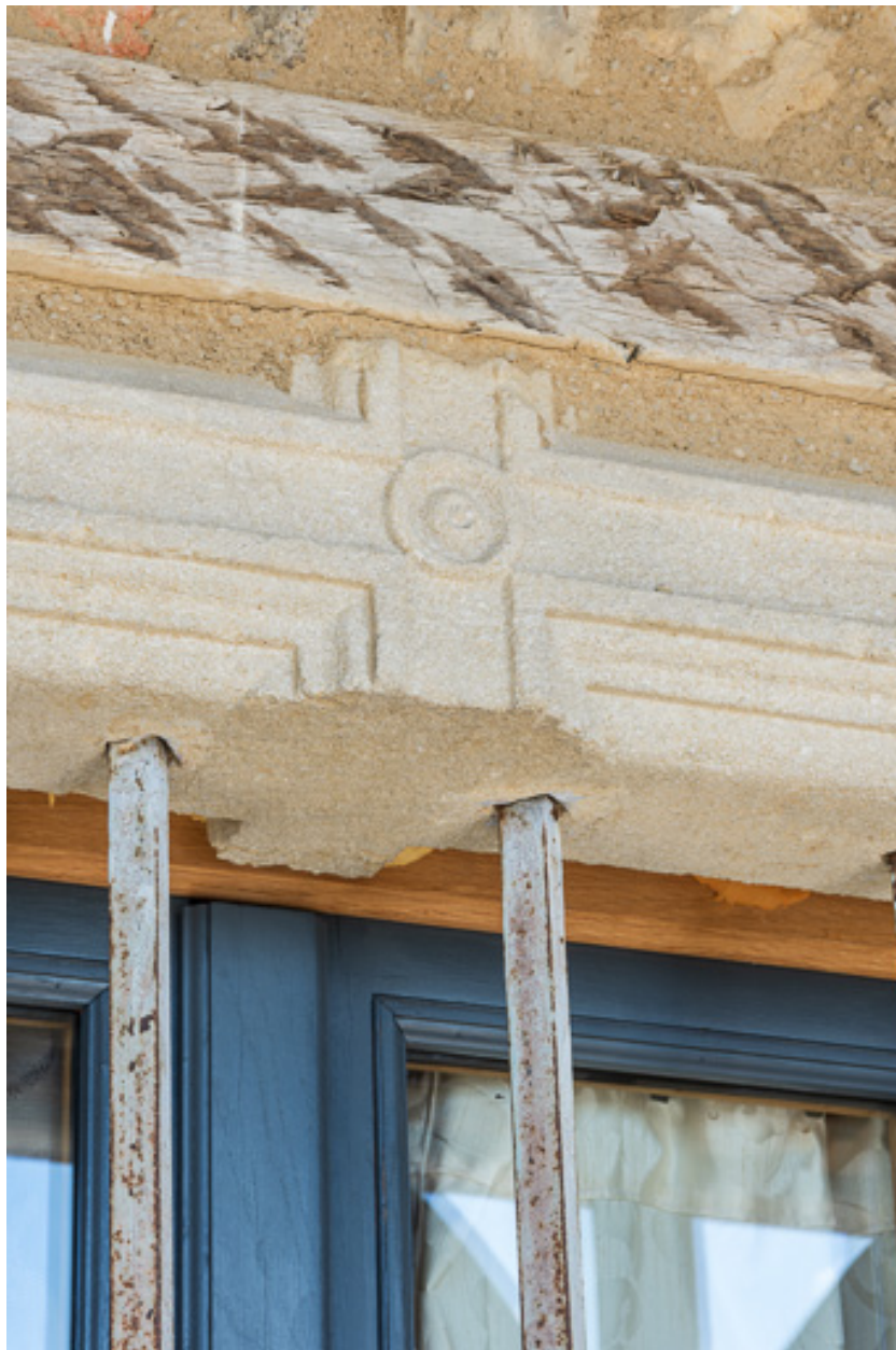
Détail d'une baie moulurée du XVII e siècle, à l'étage de la maison
