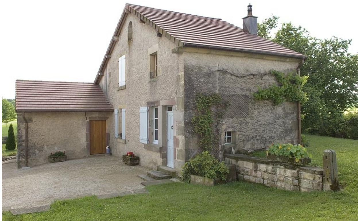
Le logement vu de trois quarts droite.
