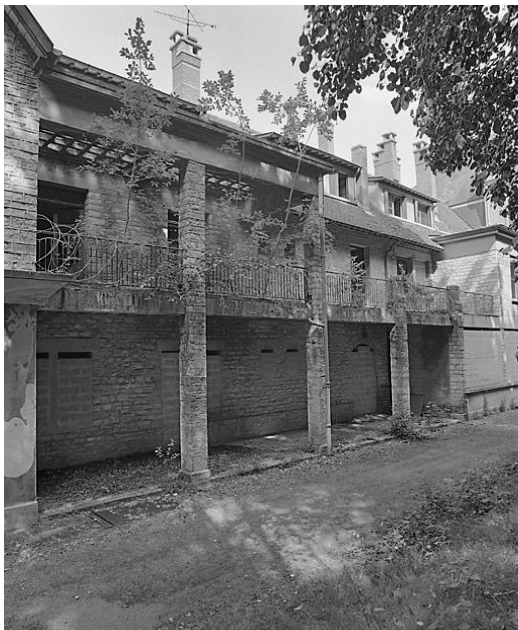
Bâtiment central, façade sud.
