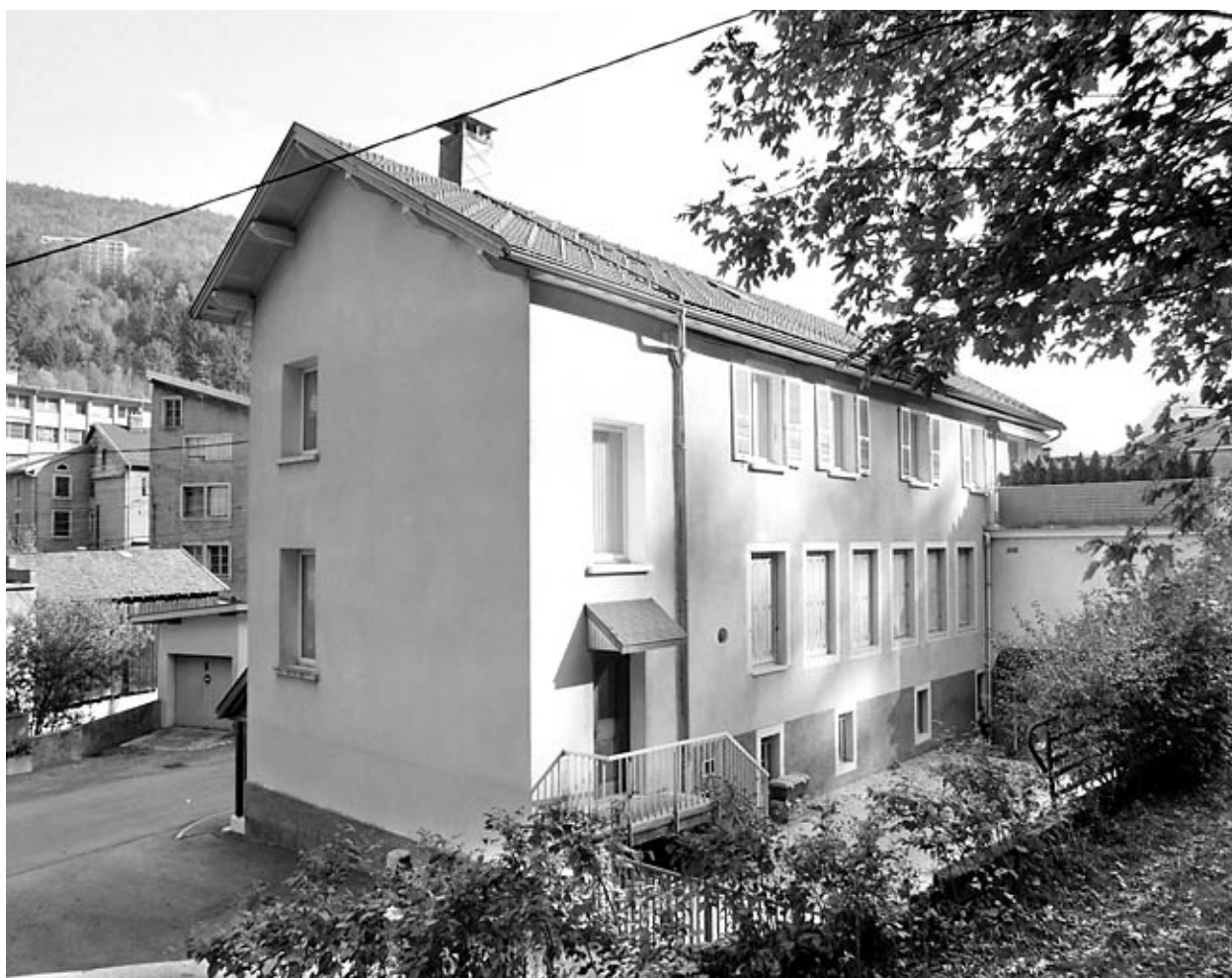
Elévation postérieure, de trois quarts gauche.
