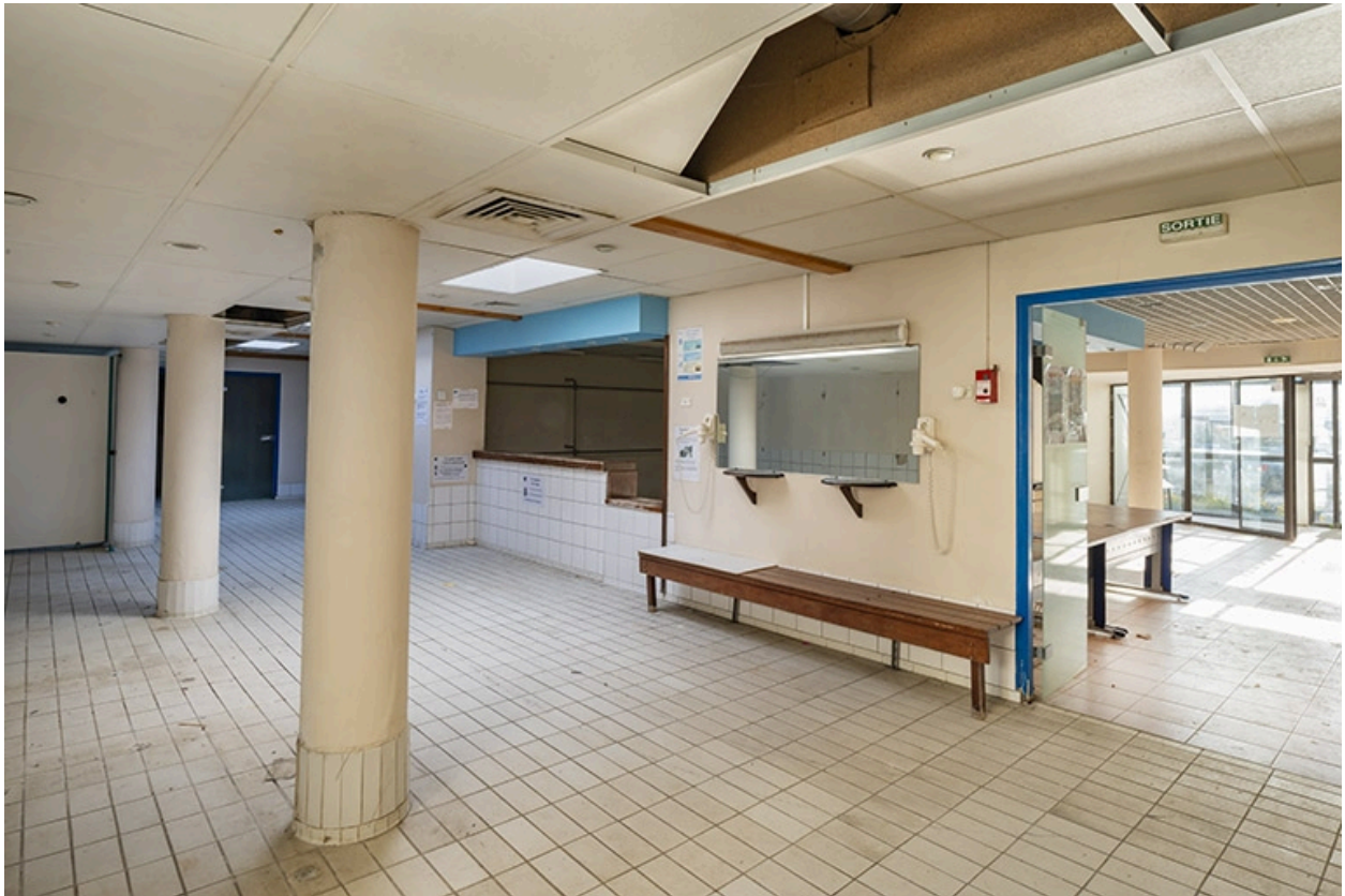
Premier étage, espace d'accueil (au-dessus de la piscine).
