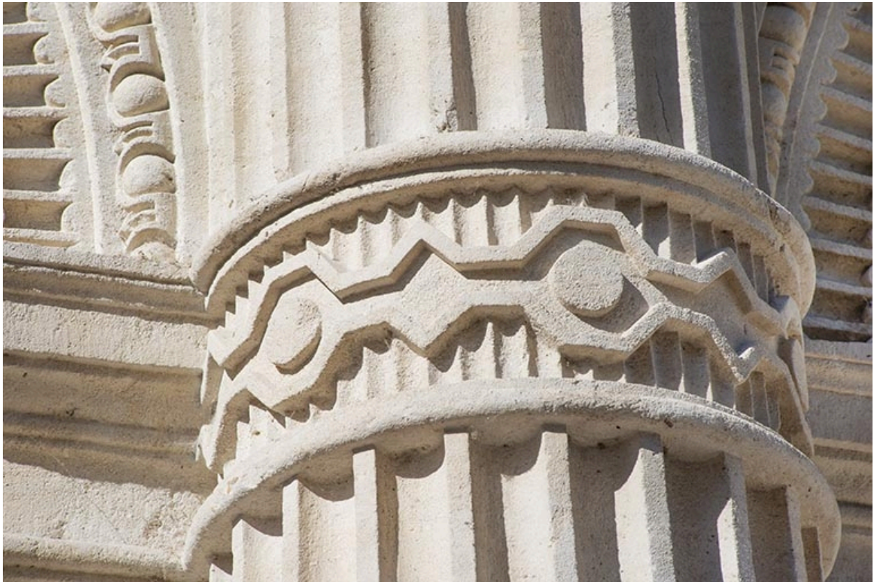
Façade antérieure, rez-de-chaussée : bague de colonne (vue rapprochée).
