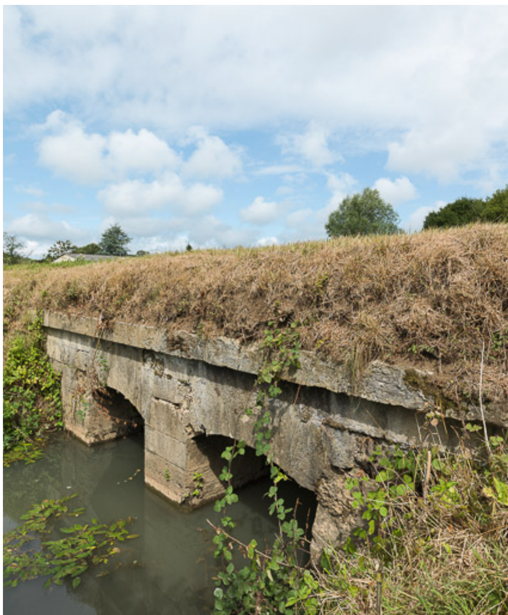
Vue de l'aqueduc.
