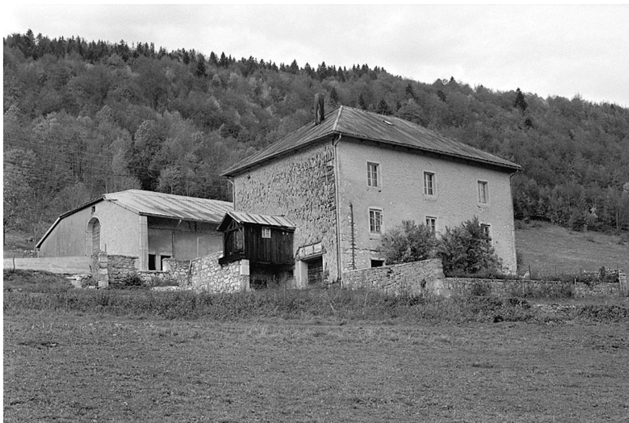
Face sud-ouest et façade postérieure.
