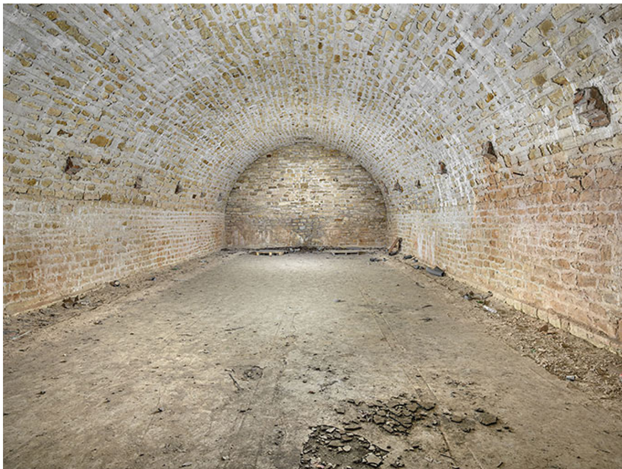
Magasin à poudre : vue d'ensemble.
