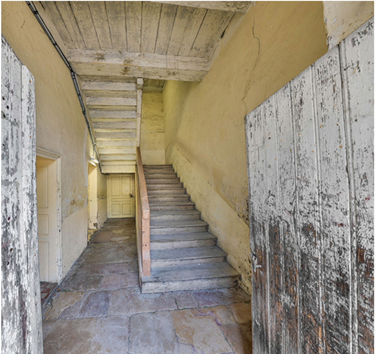
Caserne Vauban : cage d'escalier au rez-de-chaussée.
