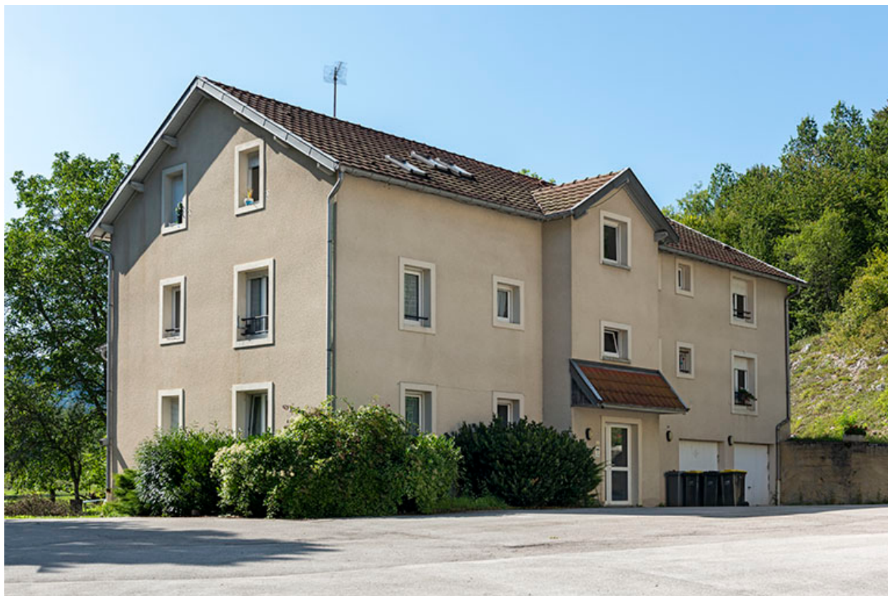
Maison : façades antérieure et latérale gauche.
