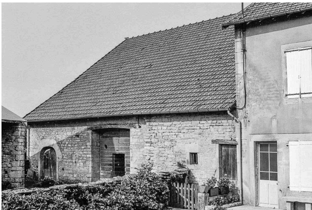
Ferme cadastrée C1 24 : façade antérieure.
