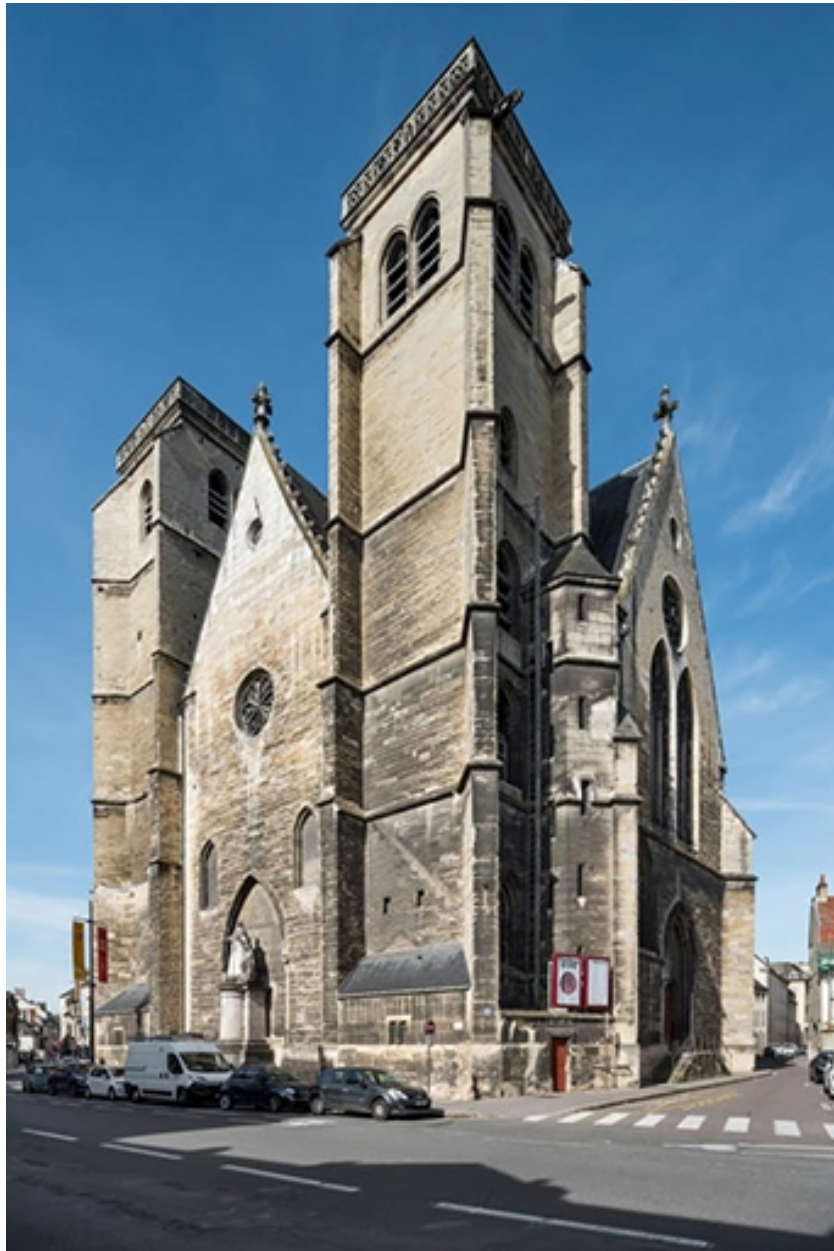
Façade orientale et tours.
