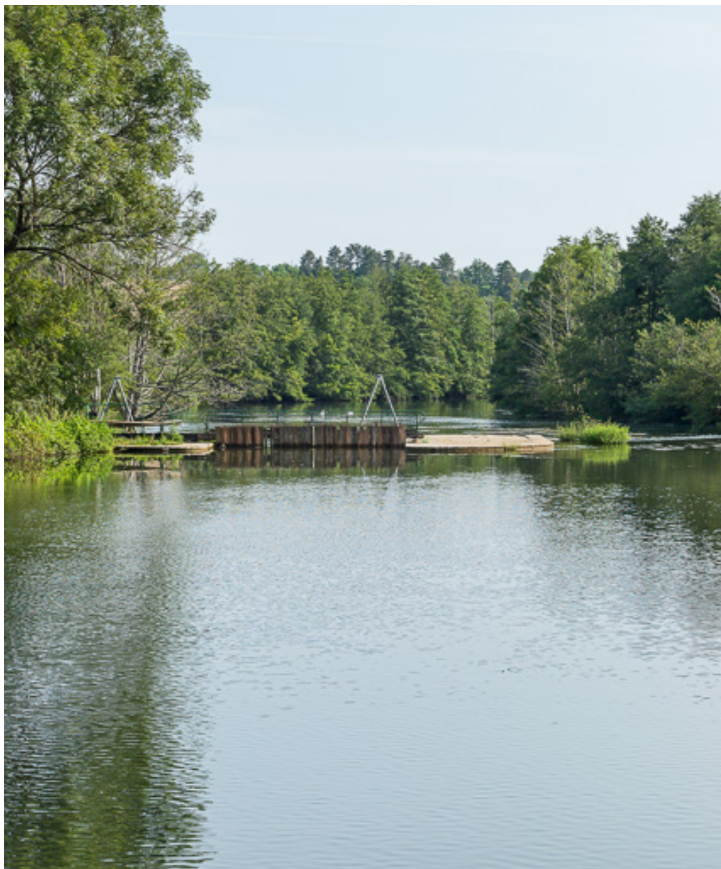
Vue d'ensemble du barrage à aiguilles.
