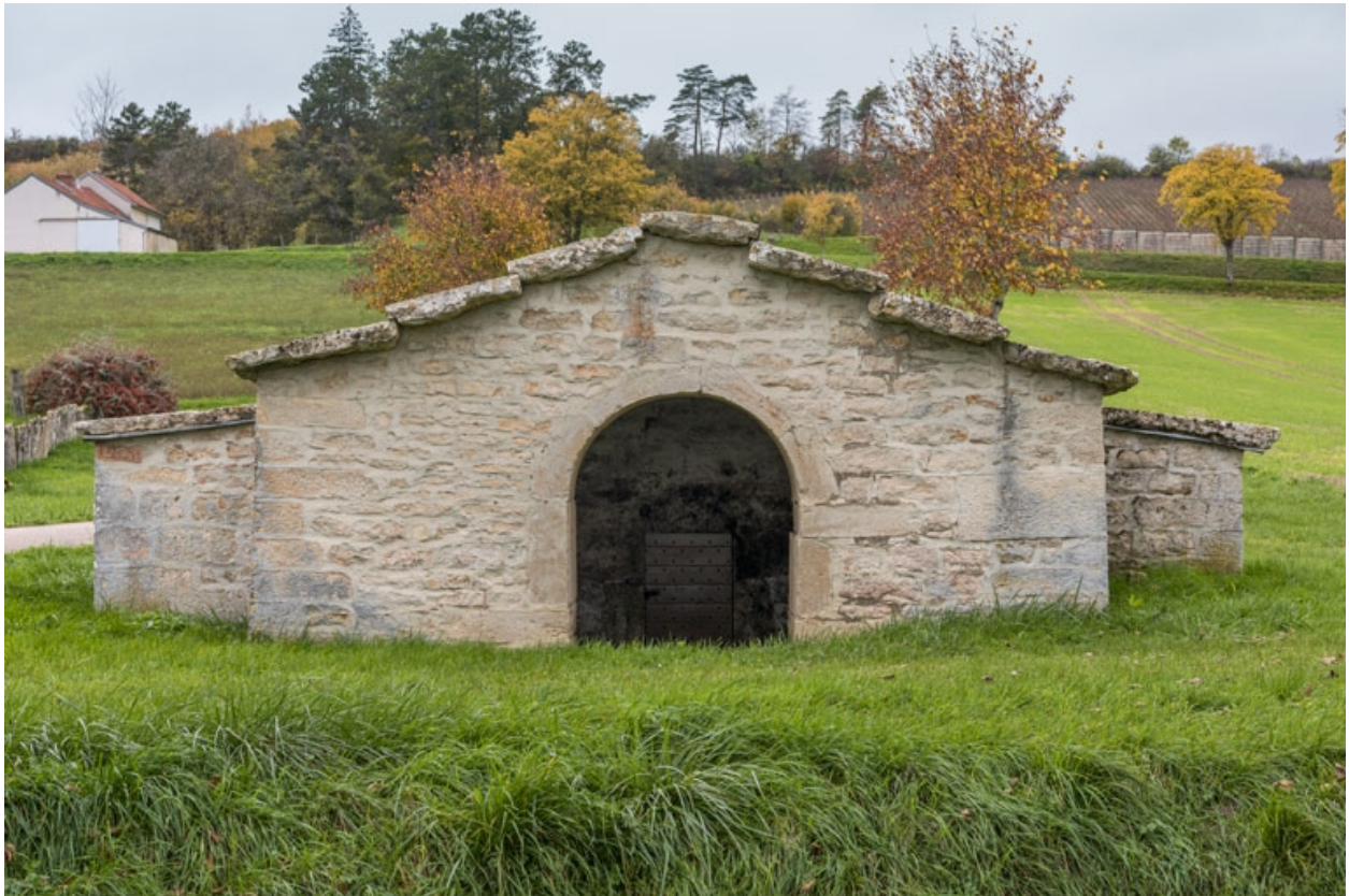
Vue de la façade est.
