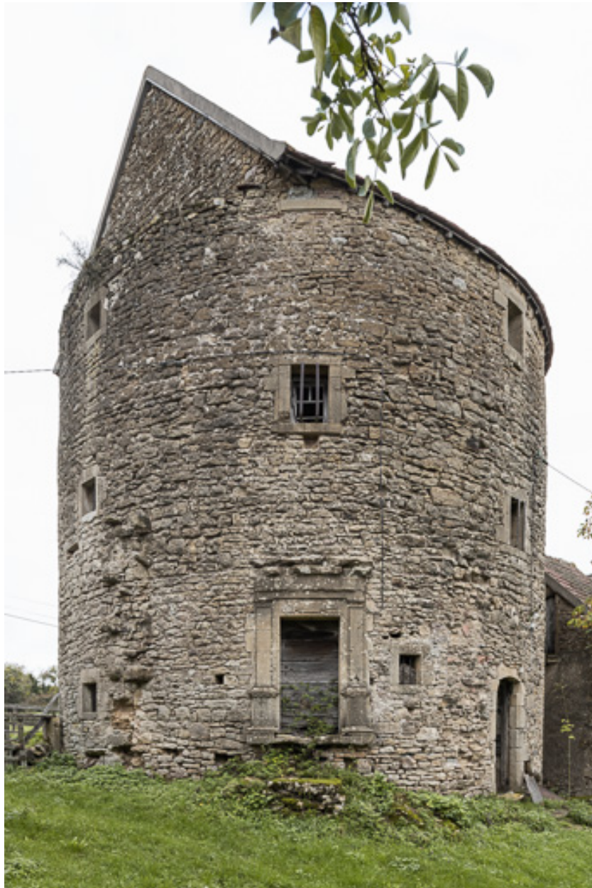
Vue de la tour de Chassagne à l'ouest
