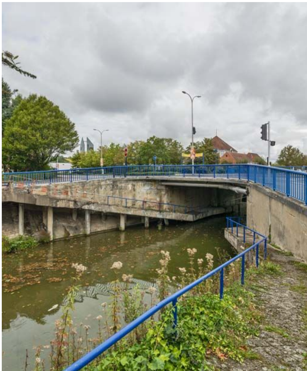
Vue d'ensemble du pont.
