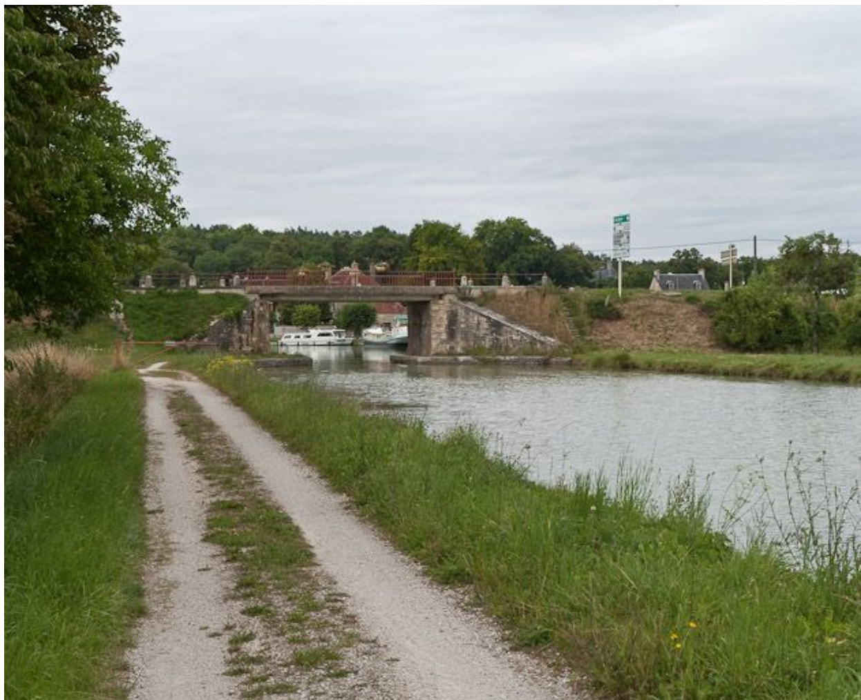
Vue du pont depuis l'amont.
