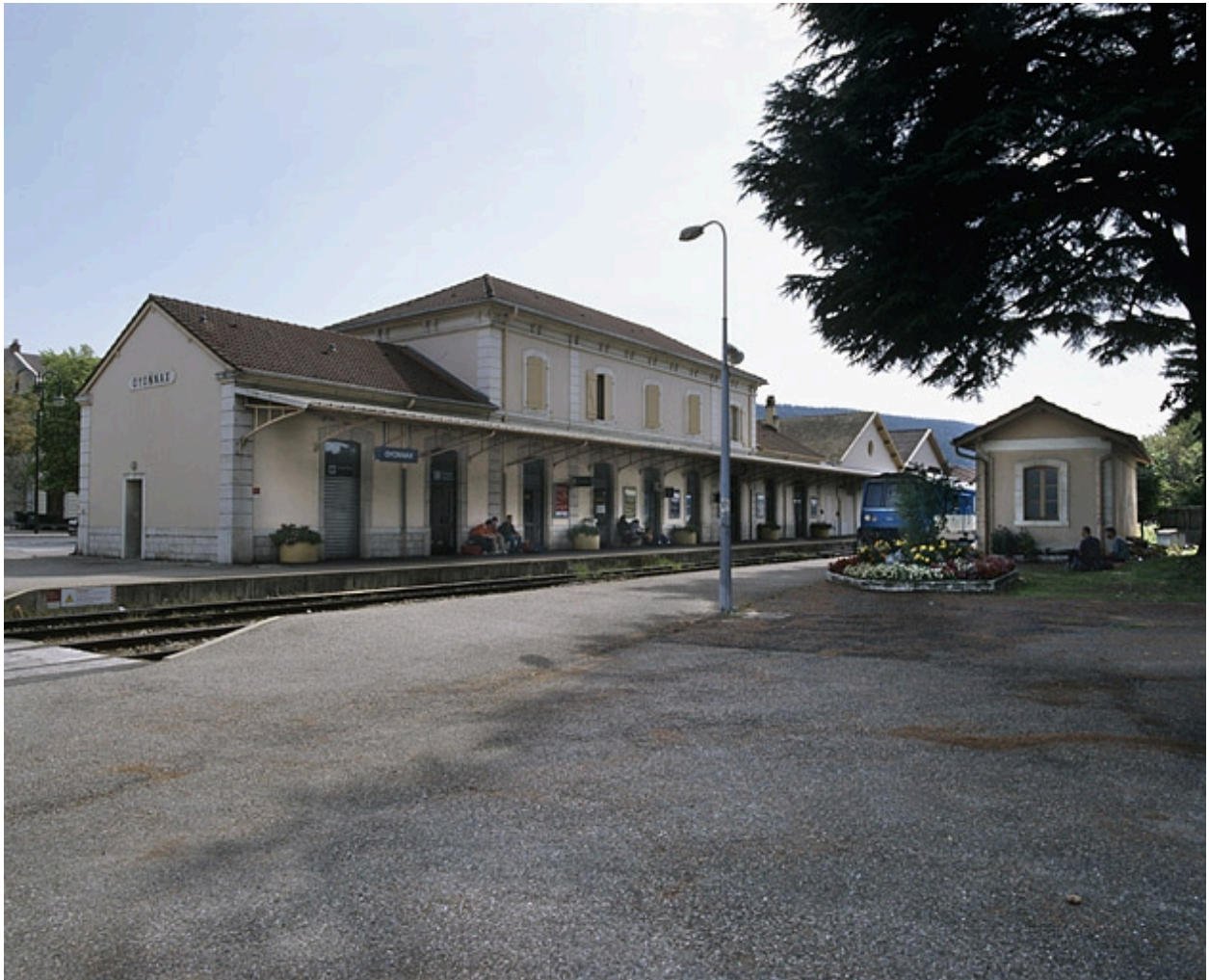
Vue d'ensemble, depuis le nord-ouest (côté Andelot-en-Montagne).
