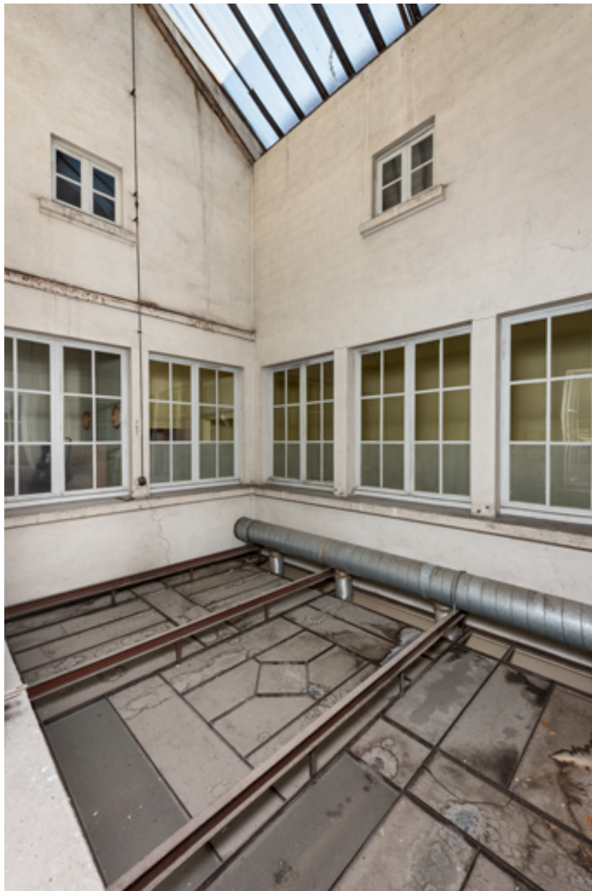
Puits de lumière au 1er étage.
