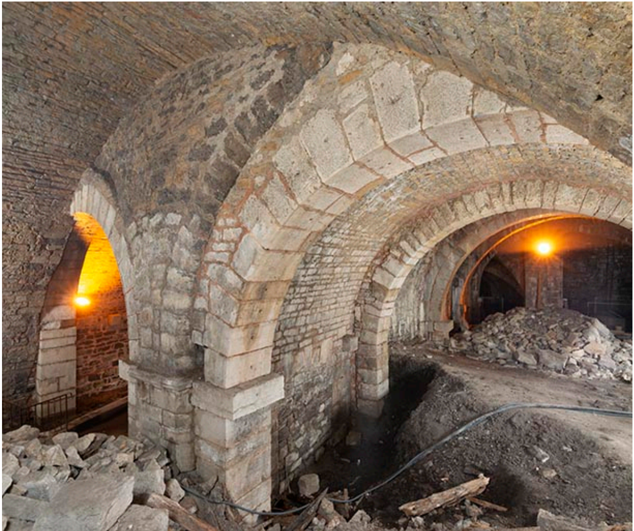
Vue du puits d'Aval depuis l'angle sud-est.
