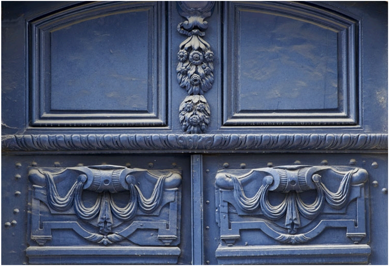
Logis principal, façade antérieure, portail d'entrée : détail du décor des vantaux de la porte.
