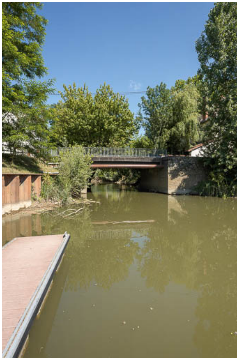
Vue d'ensemble du pont.
