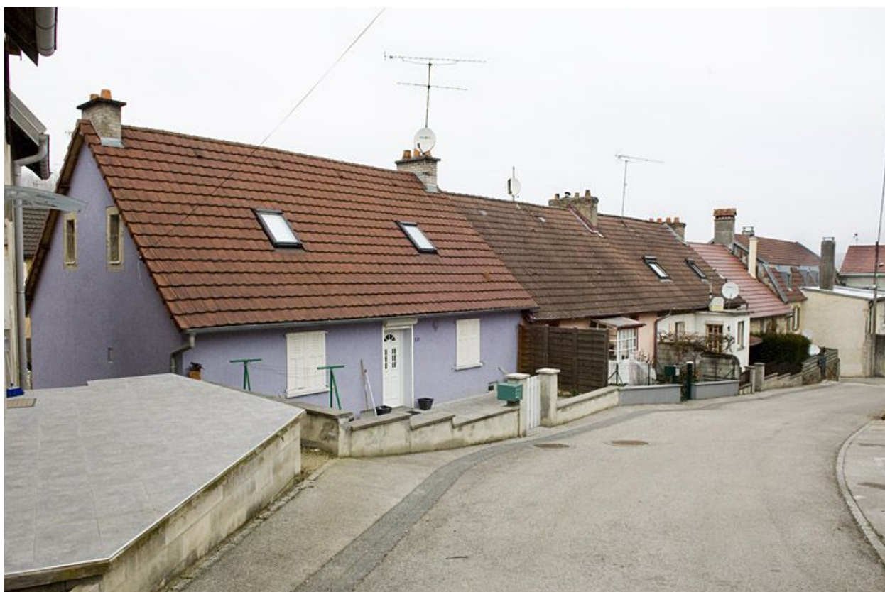
Logements ouvriers (rue de la Voûte).
