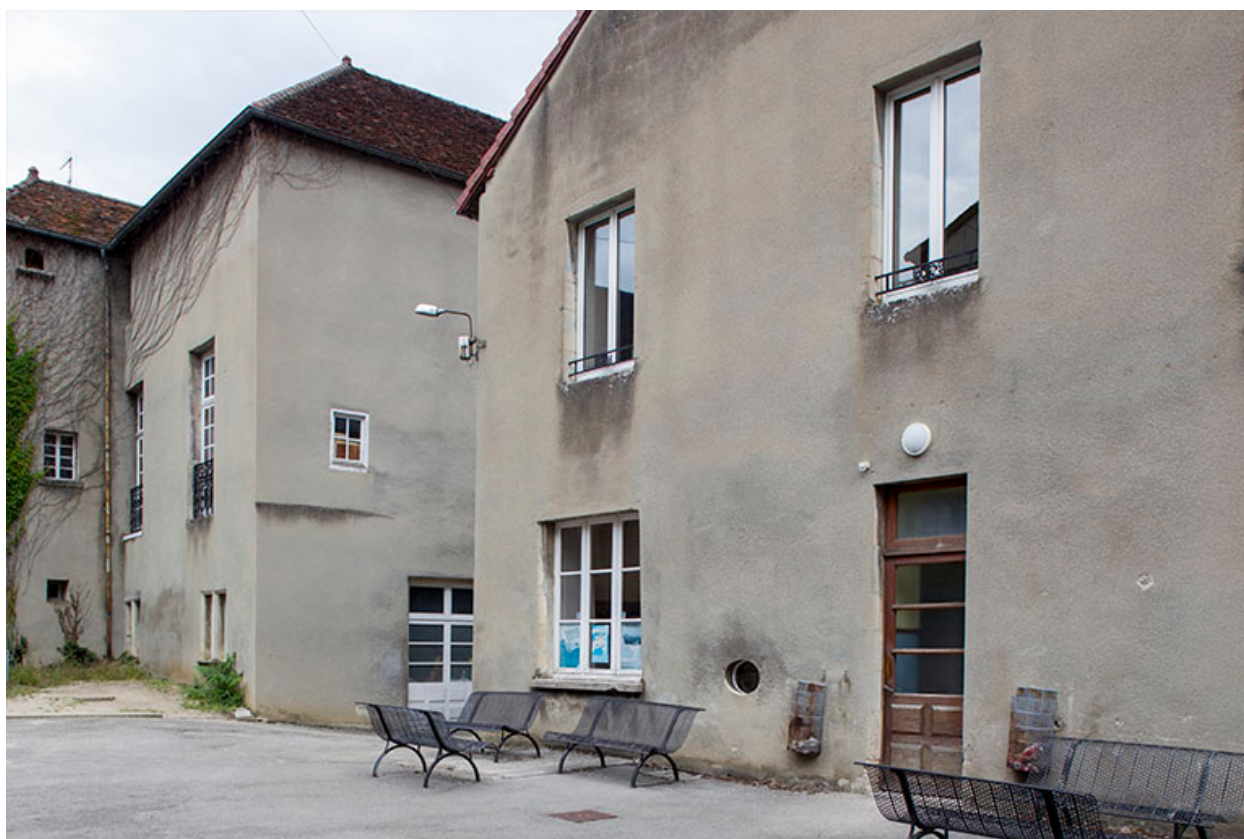
Vue des façades sur cour .
